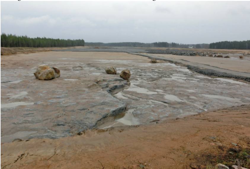
Bild 1: Område under exploatering för Eskilstuna Logistikpark, Vy från Svealandsbanan mot norr, Kjulamon, Eskilstuna kommun, 2012-11-10 Foto: Håkan Gustafson
